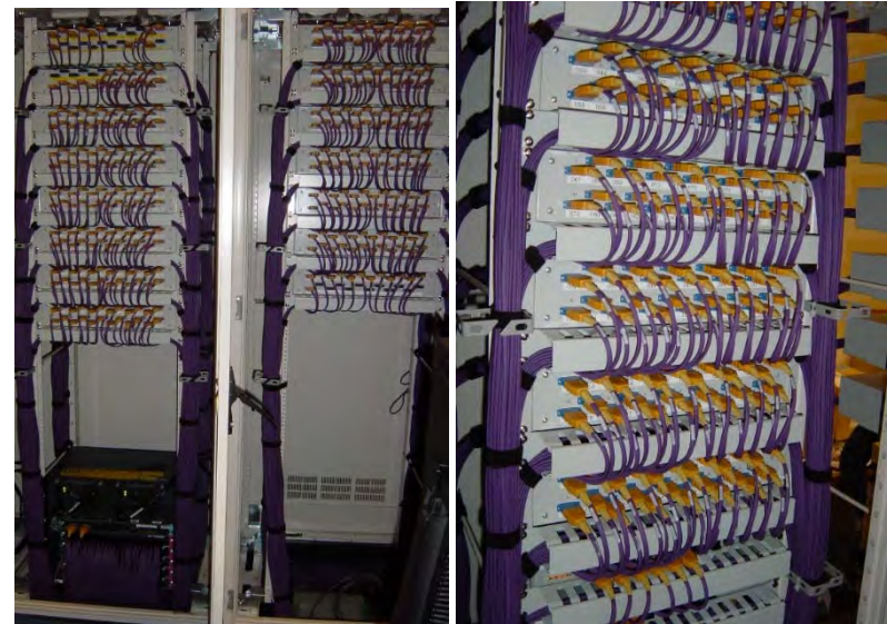
榊原記念病院内サーバー
